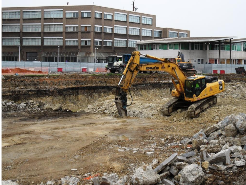
Al ser zona urbana, se debe picar la roca. Nótese la capa oscura contaminada por hidrocarburos del antiguo astillero
