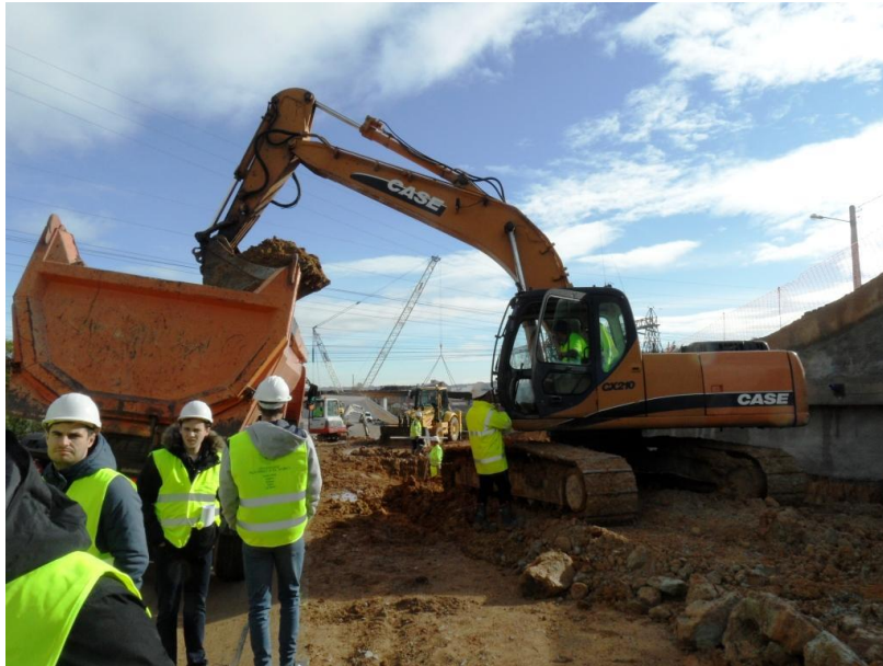
Excavación de la capa de arcillas duras frente a la pantalla de micropilotes, para realizar una sustitución de suelo bajo el futuro firme
