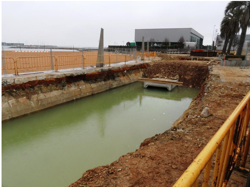
El flujo mareal en el trasdós del muro de la playa y del colector-interceptor existente imposibilita el trabajo en los ciclos de marea alta
