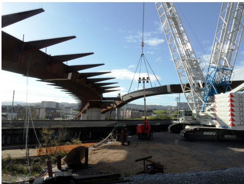
Los dos ramales en pantalón de la estructura metálica. La grúa todavía sostiene parcialmente la última pieza colocada la noche anterior, hasta que se completen las soldaduras
